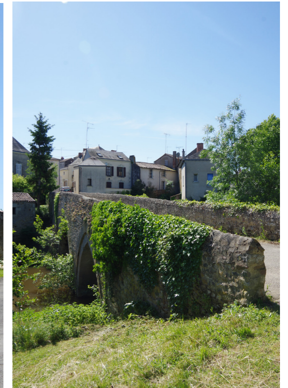
Vieux pont (MH 1) dans son écrin bâti à St-Varent
